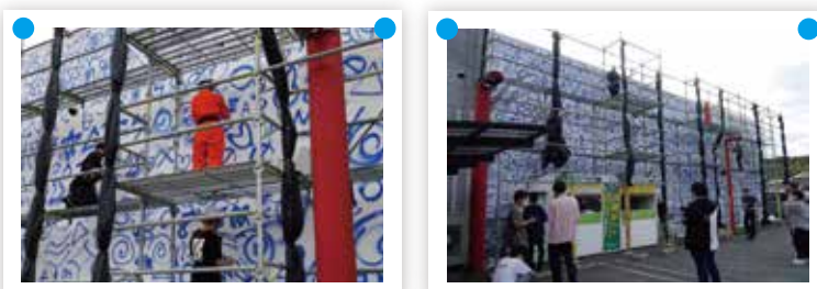
▲足場に登って作業中
